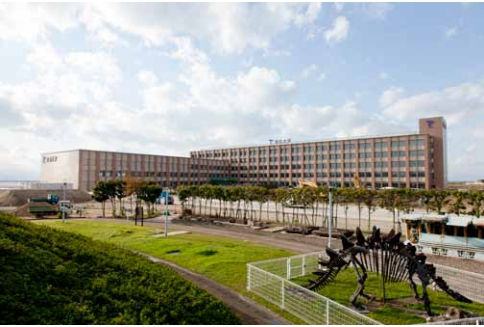
現在建設中の新福岡キャンパス
