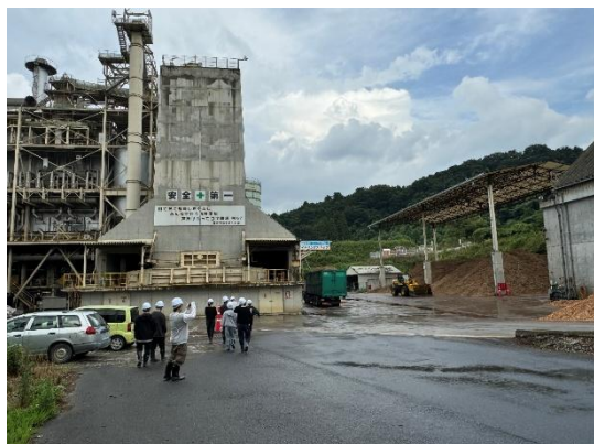
写真① 木質バイオマス発電プラント
